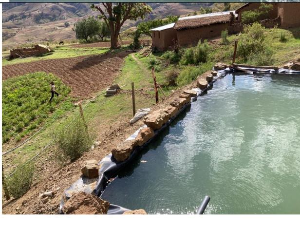
8) Adele Ferron: tank da 24.000 litri alimentato da altro piccolo invaso e da rio con portata stimata di 3-4 l/m, sifone invertito, attualmente non funzionante, ma finalizzato ad un vasto appezzamento di patate
