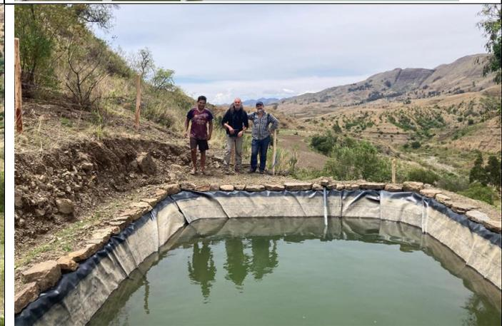
12) Innocenzo Carbayo: tank da 24.000 litri che permette l'irrigazione di una porzione di terreno prima non coltivata; la presa è da rio in aggiunta ad un'altra in origine non sufficiente a riempire il serbatoio. Attualmente il riempimento è assicurato in 2 gg e ciò porta a stimare una produzione complessiva di 5-10 litri/minuto
